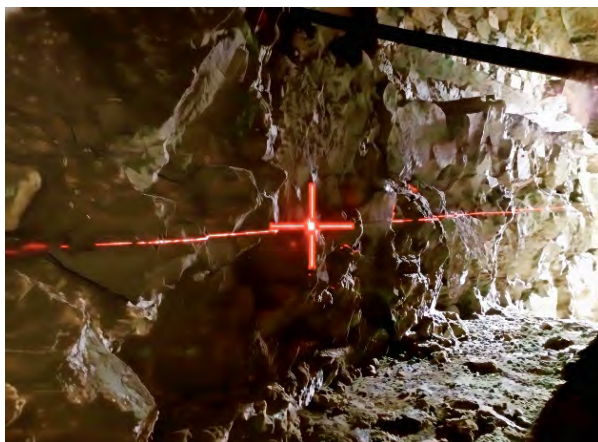
Fig. 11. Activación de pulso láser para mediciones con Disto. Fuente: Elaboración propia, 2024.
