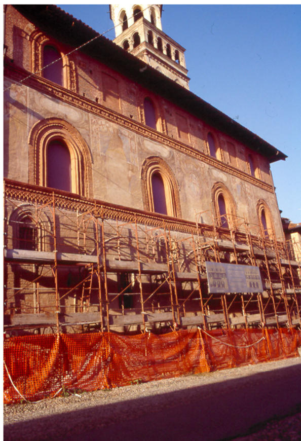
6. Fase final de las obras
