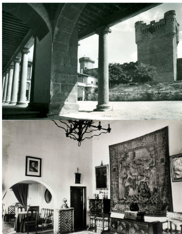
Patio y salón principal del parador de Oropesa. Fuente: Fototeca del CECLM. Tarjetas postales, ha. 1960.
