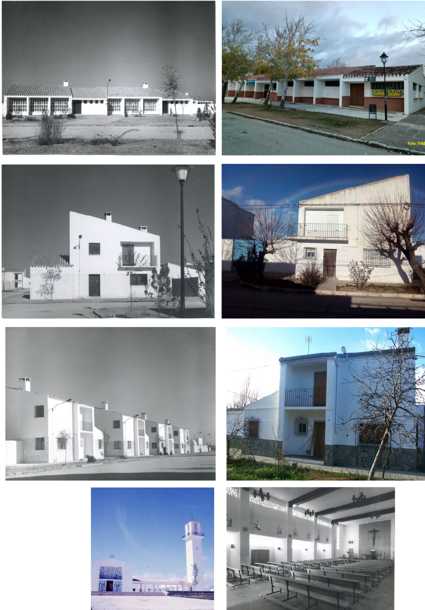
Figura 6. Aguas Nuevas antes (a la izq.) y después (a la drcha.). 1 y 2. Escuela primaria. 3, 4, 5 y 6. Viviendas de colonos. 7. Fachada, torre-campanario y galería-claustro de la iglesia. 8. Interior. Fuentes: Archivo de Pedro Castañeda Cagigas (1, 3, 5, 7 y 8), en blanco y negro: Kindel y a color: el arquitecto. Fotos del autor (2, 4 y 6).
