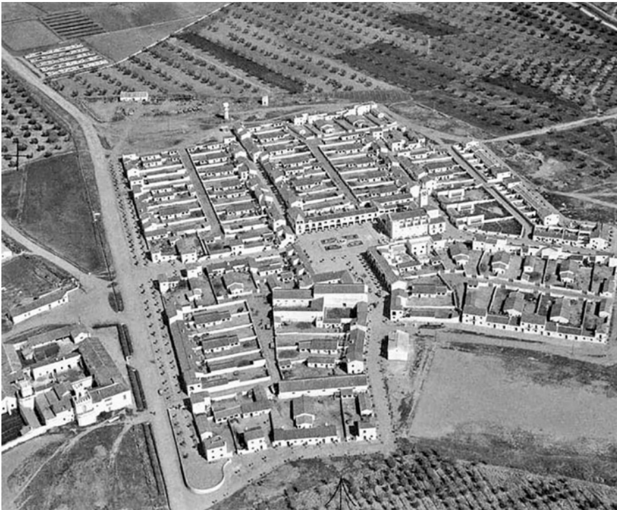
Fig.01: Foto aérea del nuevo pueblo de colonización Torre de la Reina (Finca El Viar, Sevilla), José Tamés Alarcón y Rafael Arévalo (1952). Fuente: CALZADA PÉREZ y PÉREZ ESCOLANO, 2009)
