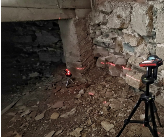
Figura 10. Posicionamiento estratégico del trípode en la toma de datos para el levantamiento de la estructura de la cabecera. Fuente: Elaboración propia ,2024.
