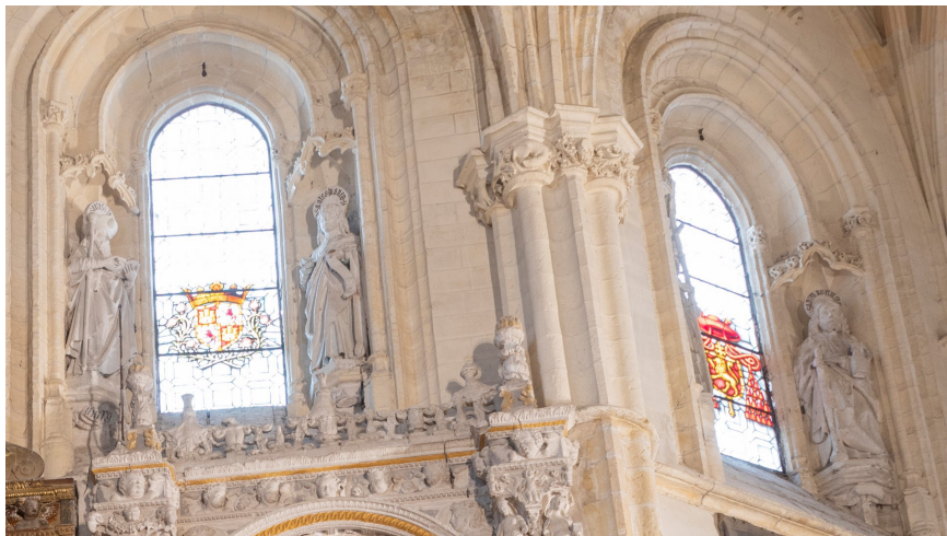
2. Ventanas del lado sur de la cabecera de la iglesia del monasterio del Parral (Segovia). Foto: autor.
