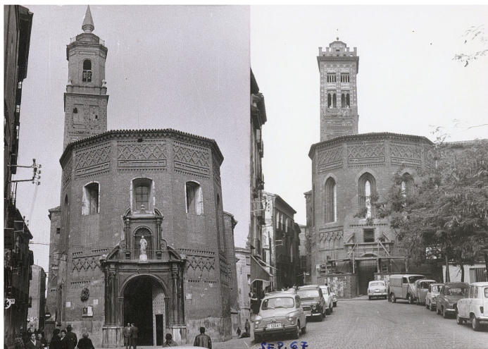
Fig. 10. Imágenes inéditas tomadas en 1967 por los arquitectos Ramiro Moya e Íñiguez Almech durante el proceso de desmonte y reconstrucción del tercer cuerpo de la torre mudéjar de la iglesia parroquial de la Magdalena (Zaragoza). Fuente: Archivo General de la Administración (AGA), Ministerio de Vivienda (04) 117.004 signatura 51/11937.
