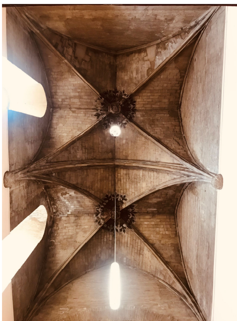
Fig. 6. Bóvedas de crucería descubiertas en la restauración de Íñiguez Almech, cubren el cuerpo de la nave de la Parroquieta, catedral de San Salvador de La Seo, Zaragoza. Estado actual. Foto de la autora.
