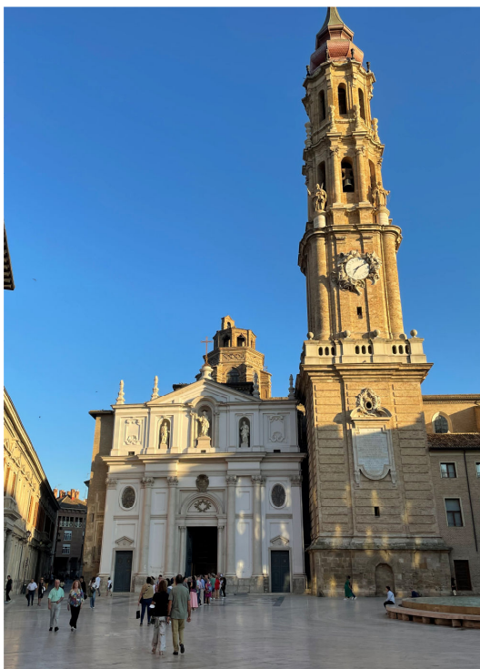
Fig. 1. Fachada principal de la catedral a la plaza de La Seo, Zaragoza. Estado actual.
