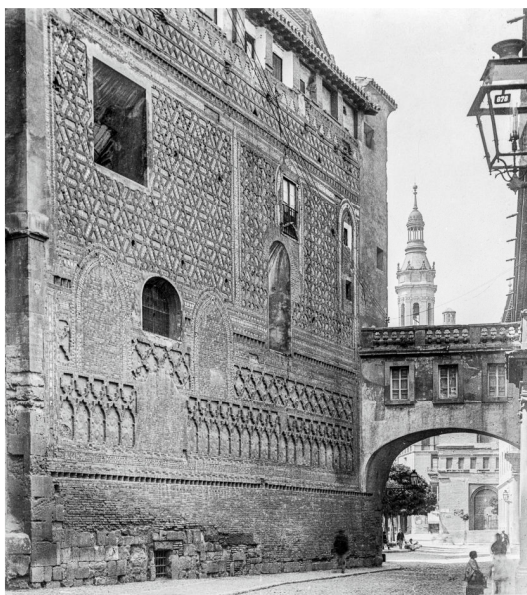
Fig. 5. Muro exterior de la Parroquieta, catedral de San Salvador de La Seo, Zaragoza. Estado previo a la restauración de Íñiguez Almech, aprox. Años 20 siglo XX Autor: anónimo. Fuente: Bildarchiv Foto Marburg.
