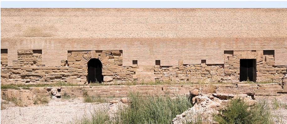
Fig. 12. Muro de cierre de la nave de los dormitorios, panda norte. Foto: autor, 2021.
