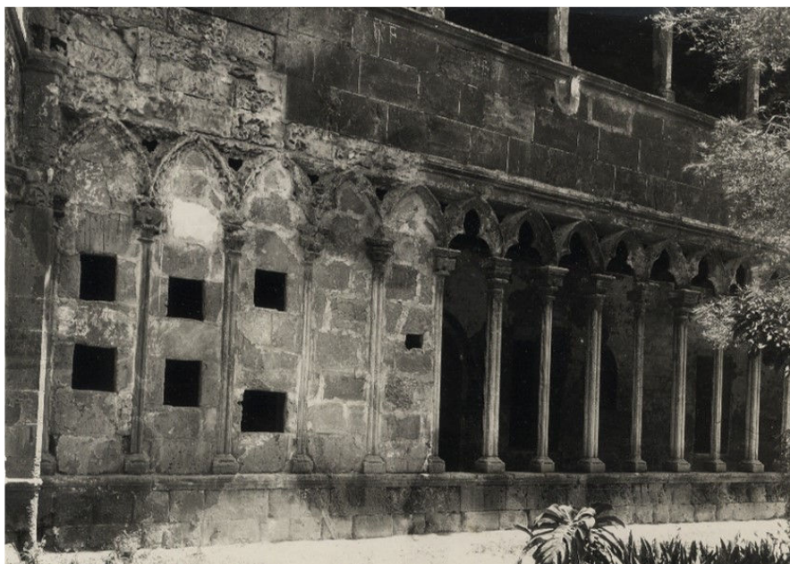
Figura 4. Fotografía que muestra la degradación de las arquerías del claustro de san Francisco de Palma. Puede observarse la afectación de los sillares y los elementos escultóricos. Parte de los vanos habían sido cegados para mantener su estabilidad. Jeroni Martorell, Proyecto de Consolidación del Claustro de San Francisco (Sección Norte), 30 de mayo de 1932. Archivo de la Diputación de Barcelona. Servicio del Patrimonio Artístico Local. Fondo Jeroni Martorell Terrats. UI 31. L/C31/d63
